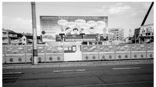
三条通から見た工事現場
